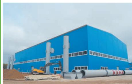
На стройплощадке будущего завода по переработке тонкомерной древесины доставлены все четыре дымовые трубы новой котельной, начался их монтаж. Установка всех труб будет завершена к 20 октября, после чего начнутся пуско-наладочные работы.
