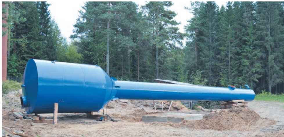
Устанавливается водонапорная башня около здания Устьянского лесничества
