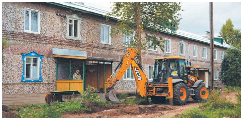
Работы ведутся по ул. Ленина, д.46
